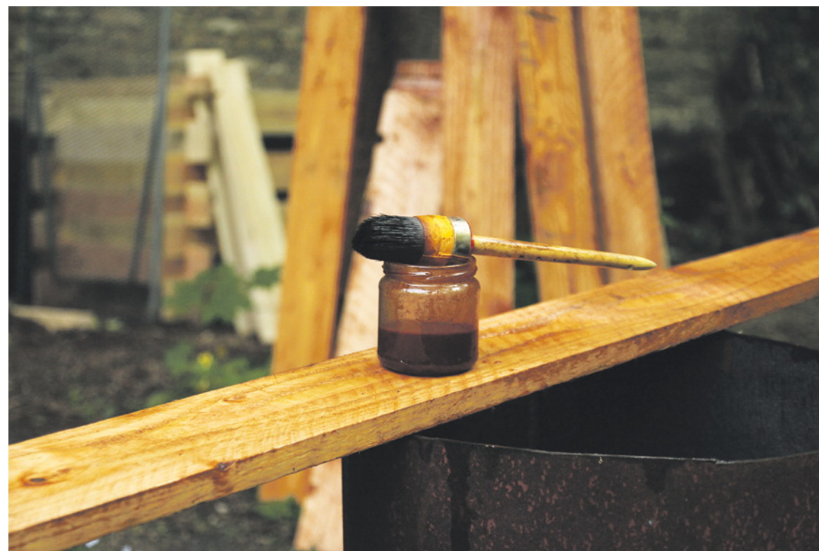
Mit einem Farbmix aus Rotwein und Leinöl werden die zukünftigen Komposteile bepinselt.
